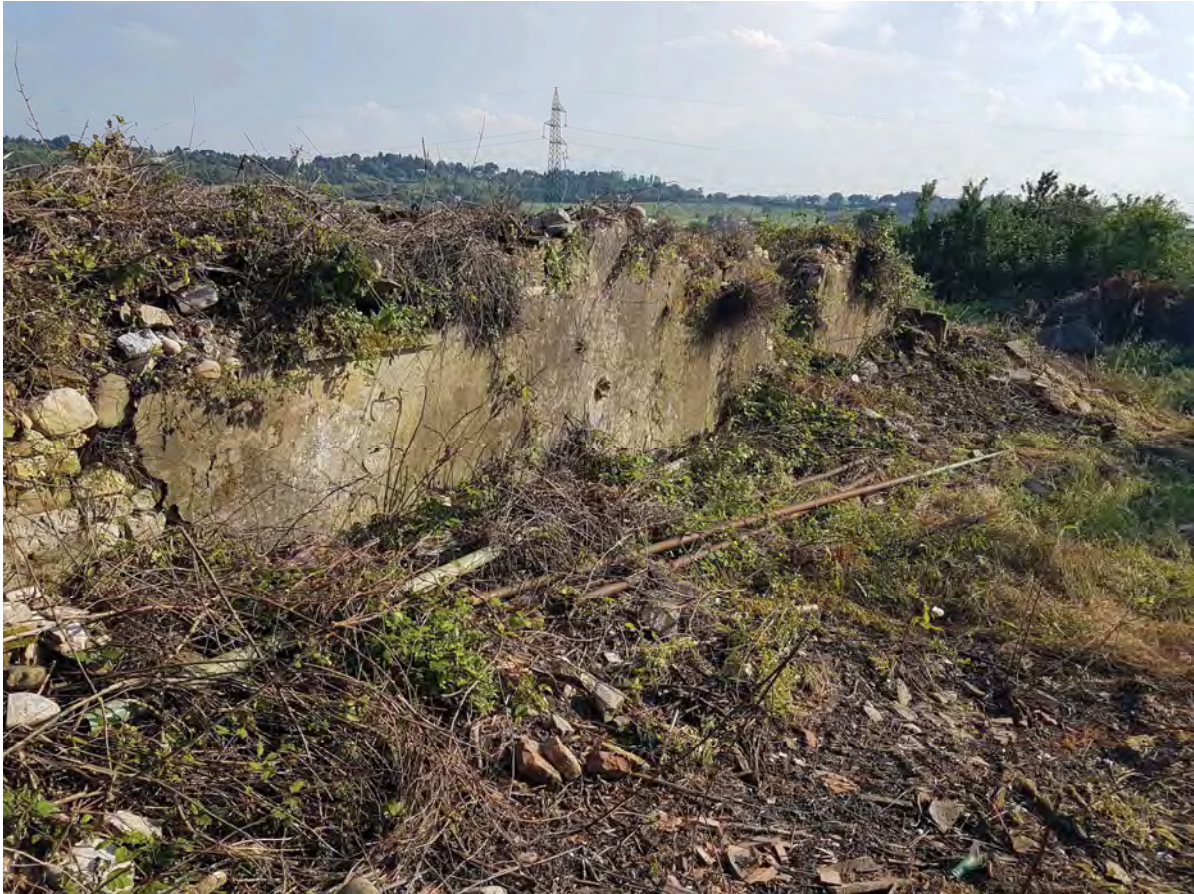
Rudere manufatto agricolo preesistente lungo la strada interpodereale interna all'area
