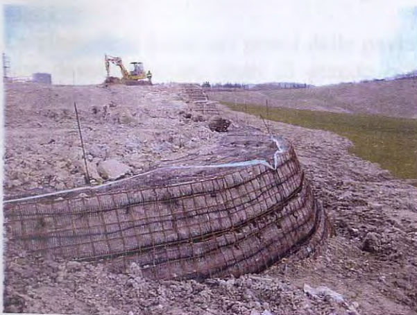
(terre armate per la stabilizzazione dei versanti)
